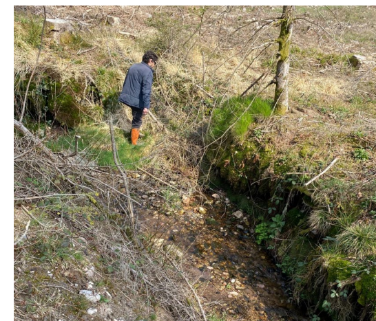
Section de lit fortement creusé dans la partie artificialisée du ruisseau (>1m de profondeur de berges)
