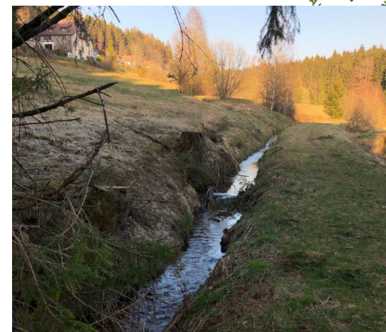
Section canalisée et rectiligne du ruisseau de la Vigotte en contournement des étangs
