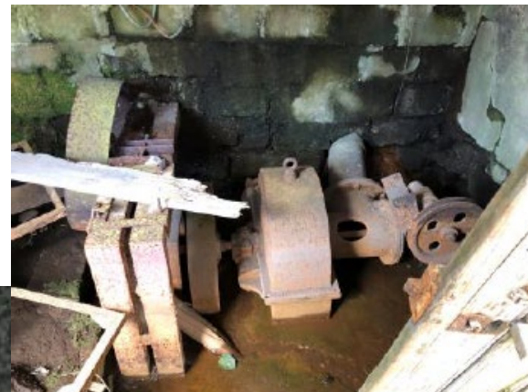
Ancienne turbine désaffectée
