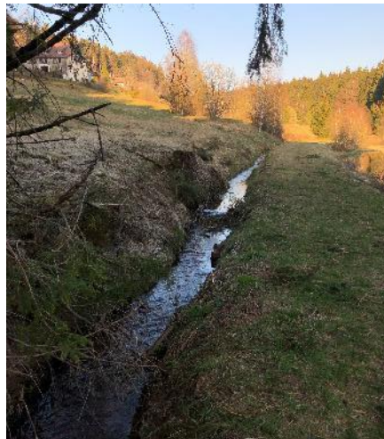
Etat Initial : le ruisseau détourné et son lit rectiligne, sans ripisylve
