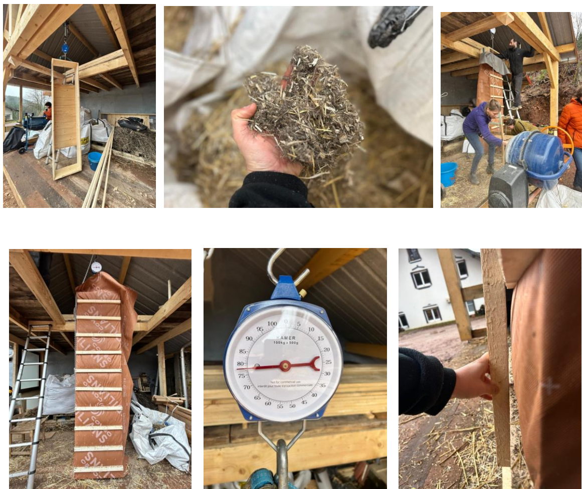
Figure 22 Prototypage du caisson d'isolation en mélange de fibres et de pailles hachées
