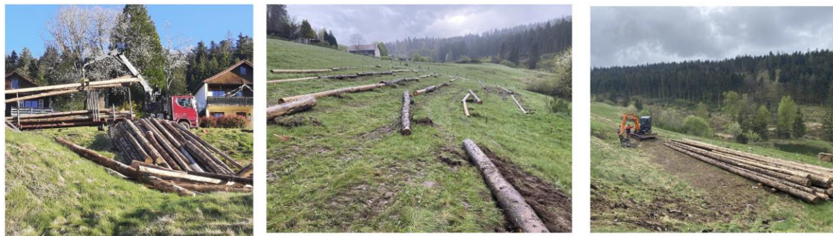
Figure 2 Réalisation des terrasses de culture (collecte de grumes scolytées locales pour réaliser les soutènements, disposition suivant les courbes de niveau à l'aide d'une minipelle équipée d'un grapin et à partir de mesures réalisées au "Niveau égyptien").
